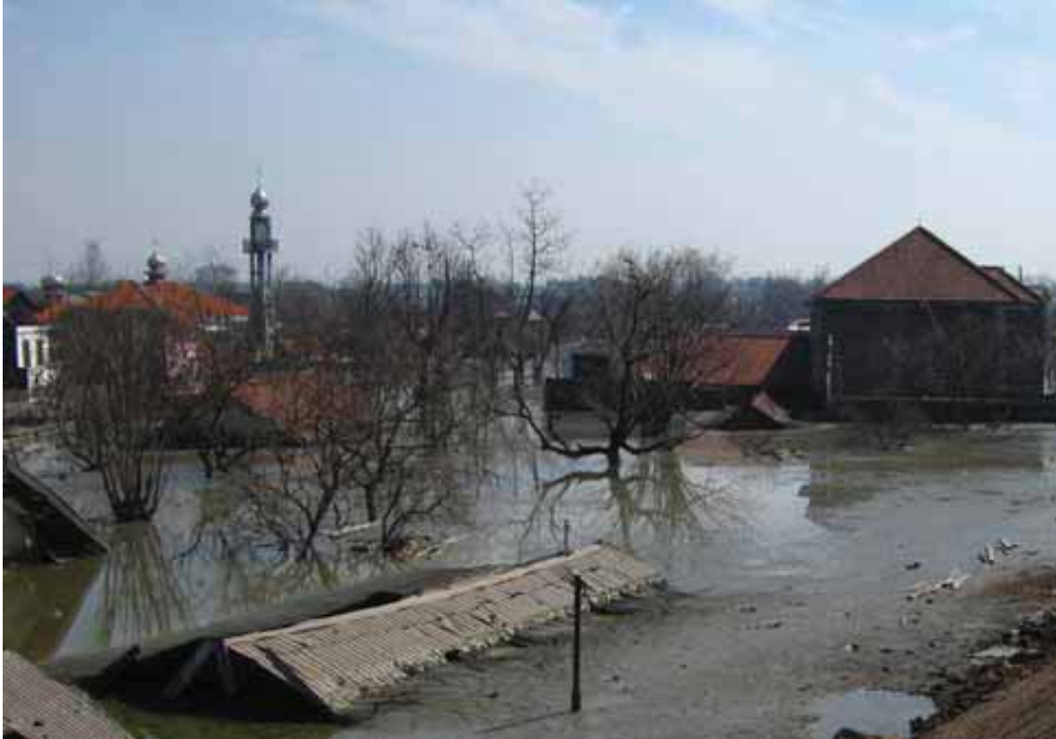
GAMBAR 2. Dampak dari genangan lumpur. Catatan kedalaman lumpur dalam kaitannya dengan tingginya atap bangunan yang berdekatan ke Kolam Lusi. Foto diambil 29 Mei 2007. © Atkins Ltd 2007.
