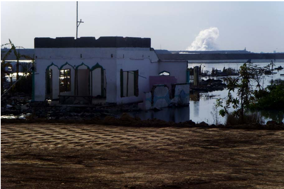
Gambar 70. Masjid di Desa Renokenongo terpaksa harus ditinggalkan warga, sehubungan pembangunan Tanggul Renokenongo, sebagai benteng pertahanan di sektor timur laut.
